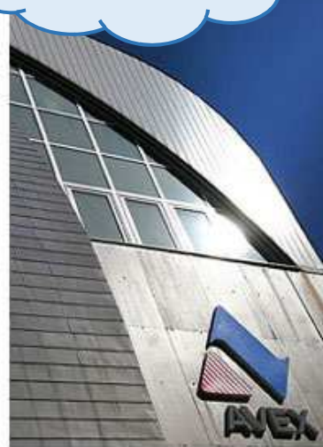
本社第一工場
