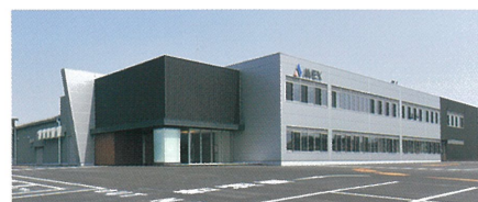
桑名先進工場全景
